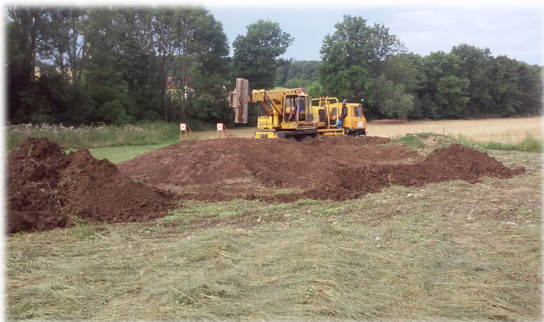
Úprava terénu vedle hasičského hřiště na malý bikepark.
